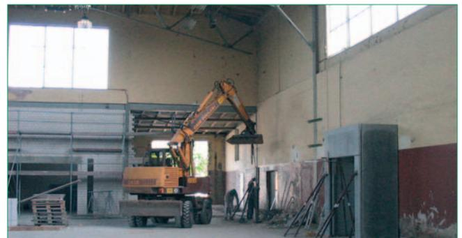
Im Bereich der Umkleieräume werden die letzten Eingangselemente aus Stahlbeton gesetzt.
