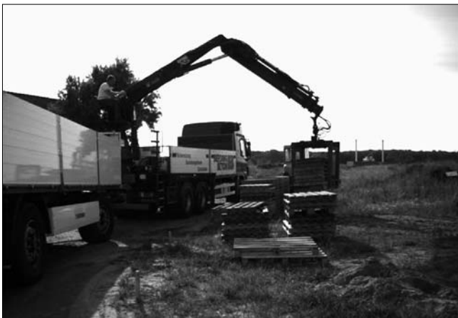
Hengstkoppelweg - Material wird angeliefert
